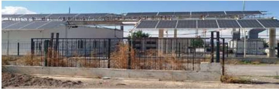
Şekil 6. Enerji Dönüşümleri Araştırma ve Uygulama Merkezi çatısına kurulmuş fotovoltaik güneş enerjisi sistemi
